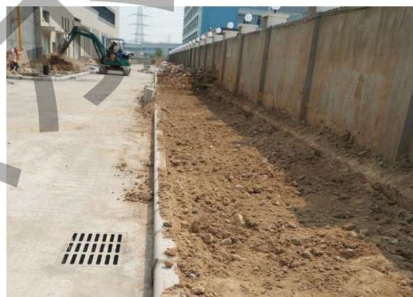
绿化回填土施工 (2019.10)
