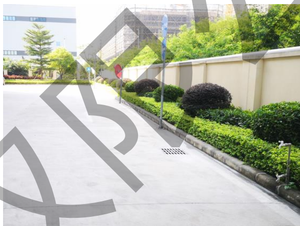
硬地内雨水口及绿化（2021.10）
