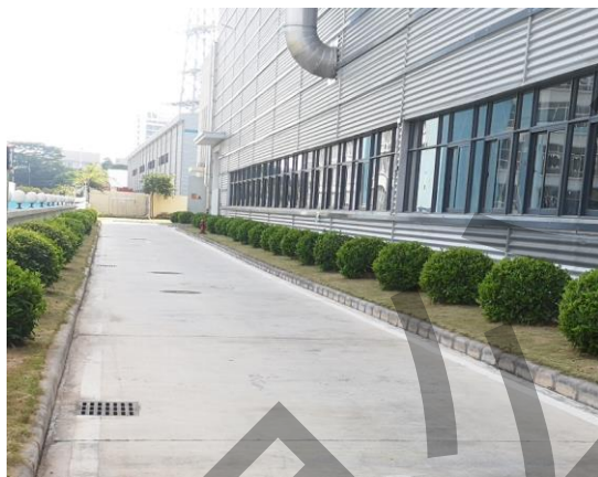
道路侧雨水口 (2021.10)
