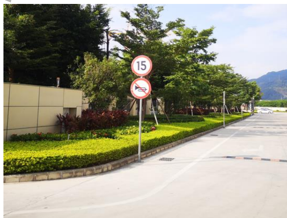
道路上雨水口及绿化（2021.10）
