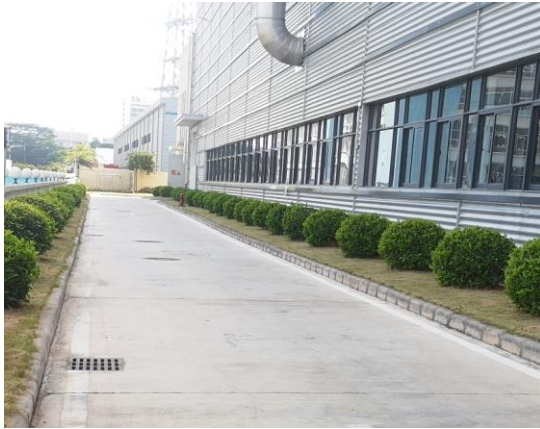
道路侧雨水口（2021.10）
