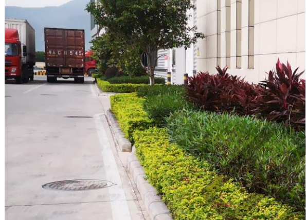
道路上雨水检查井（2021.10）
